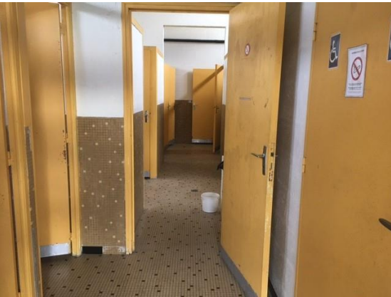
Sanitaire du camping avant travaux
