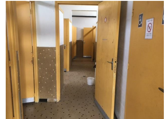
Sanitaire du camping avant travaux
